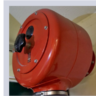
■ Tuloilmanpaineventtiili, jonka sisällä on esisuodatin.
