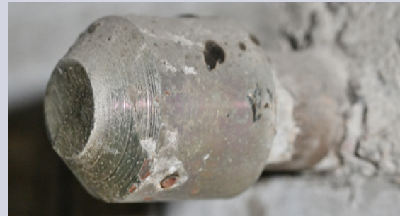
■ Ylipainemittarin mittaputken ulko-osa.
